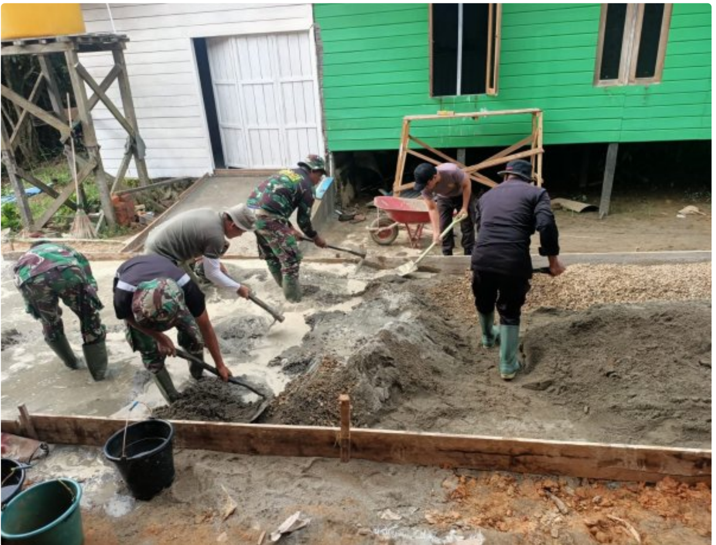
Aduk Semen Dengan Cangkul dan Skop Kebut Pembangunan Semenisasi Jalan TMMD
